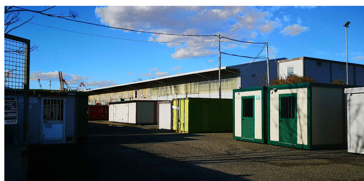
FOTO 6: Capannone artigianale adibito a deposito
