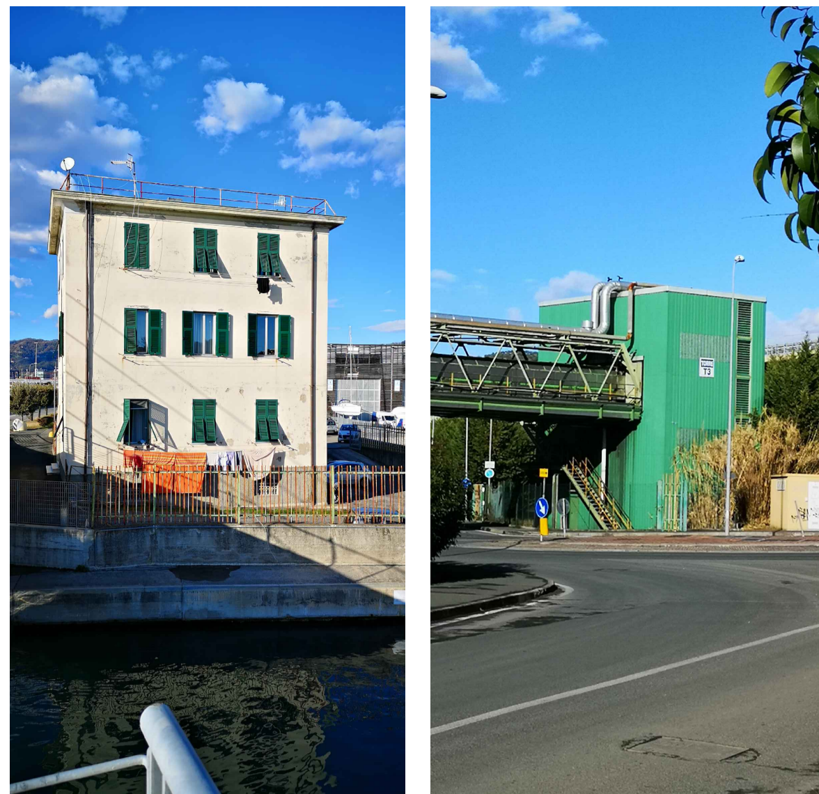
FOTO 1: Edificio residenziale a tre piani tipologia in linea
