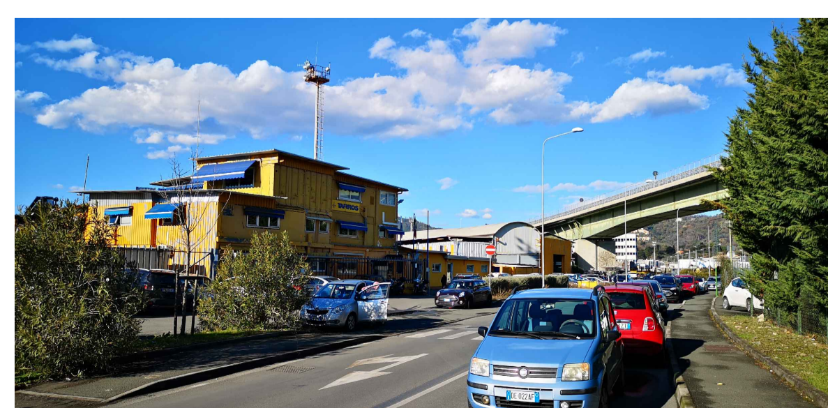
FOTO 14: Edifici artigianali-logistici area retroportuale
