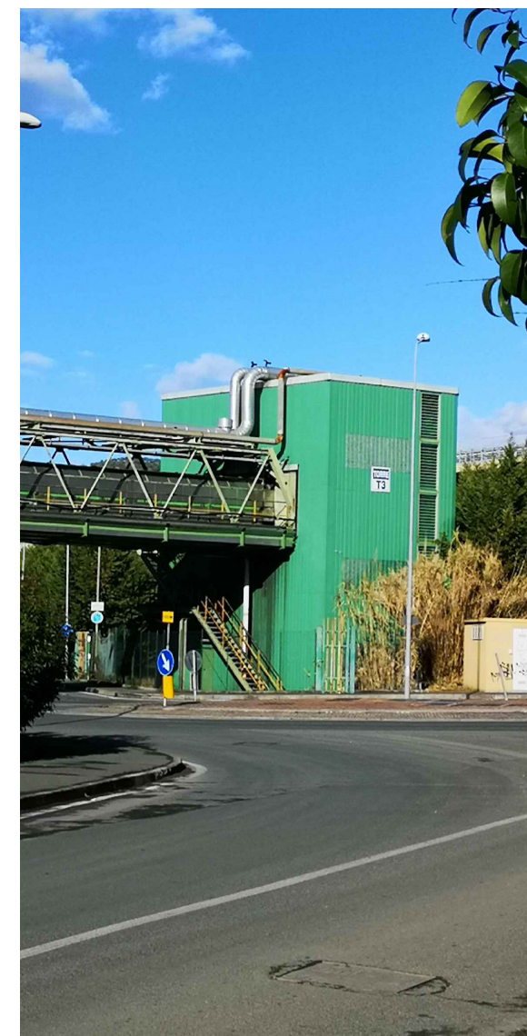
FOTO 13: Torre per nastro di alimentazione carbone Centrale ENEL
