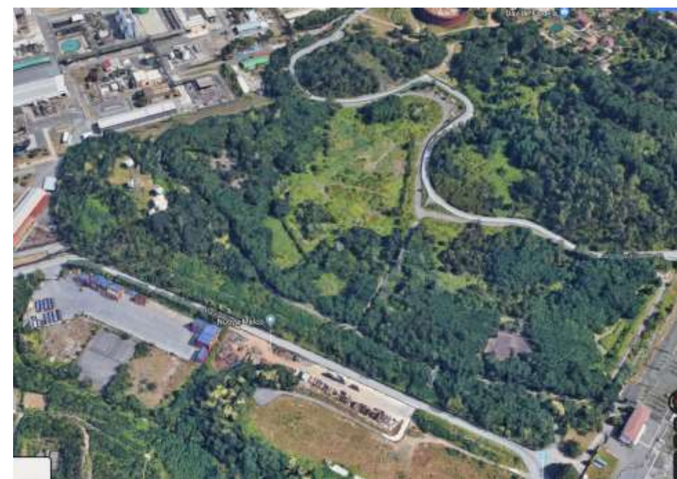
Vista satellitare area Bacini di Lagunaggio
