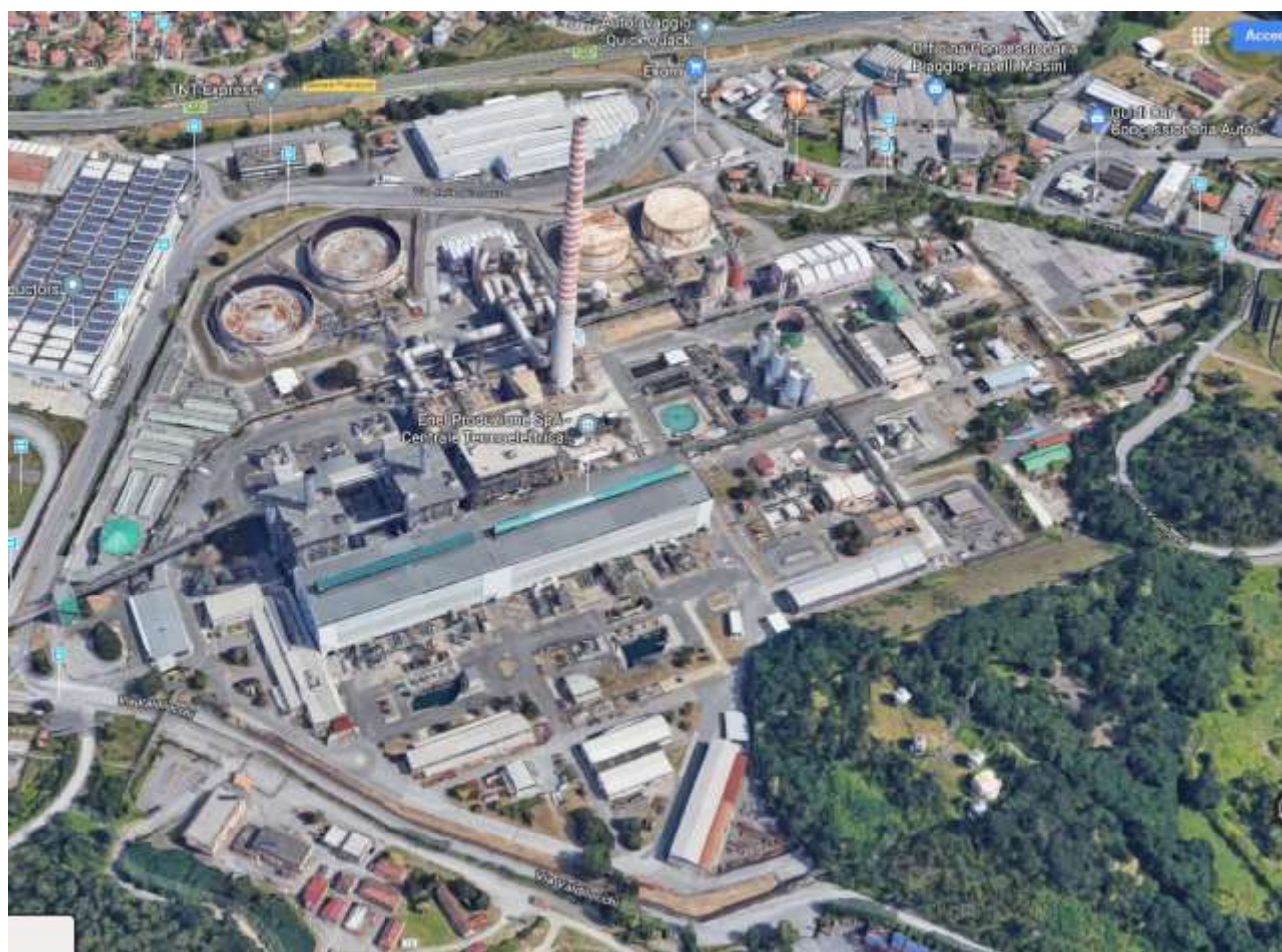
Vista satellitare area Centrale Enel
