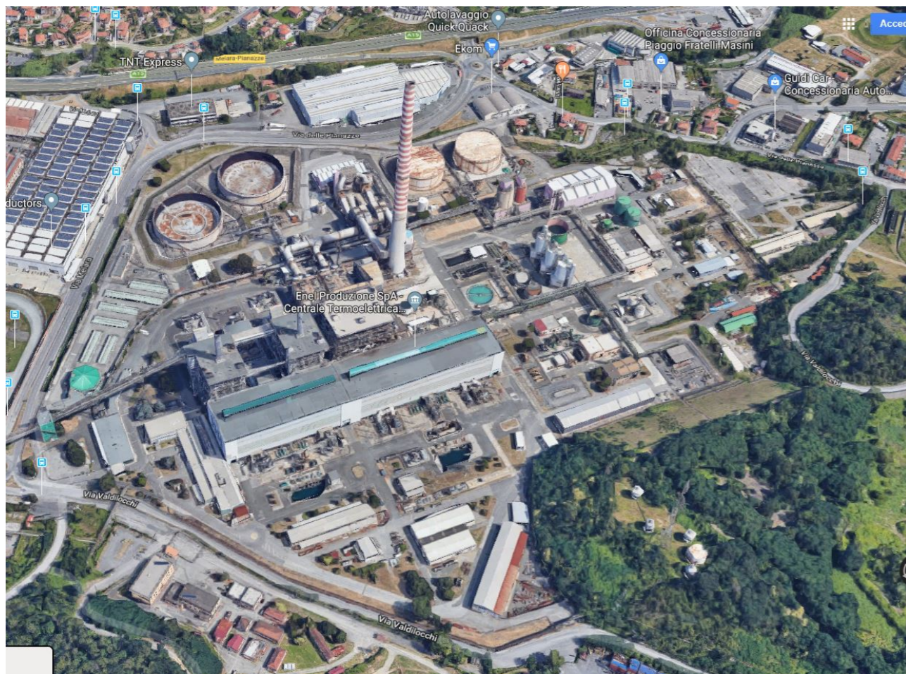
Vista satellitare area Centrale Enel
