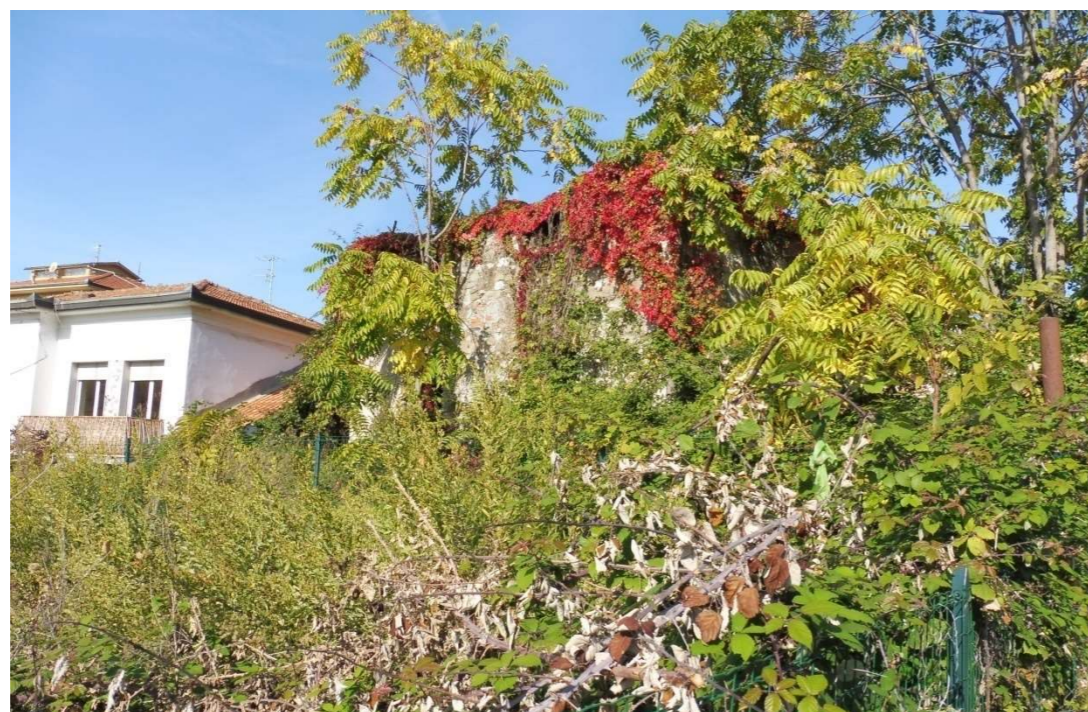
Edificio colonico fatiscente su Via della Pianta
