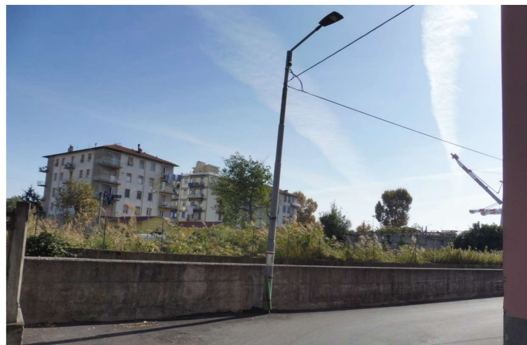
Veduta dell'area da Via del Tino verso Sud-Est
