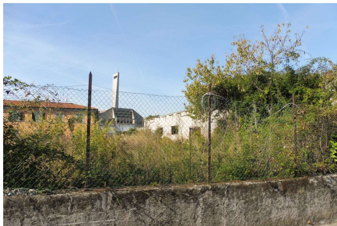
Veduta dell'area da Via della Pianta verso Ovest
