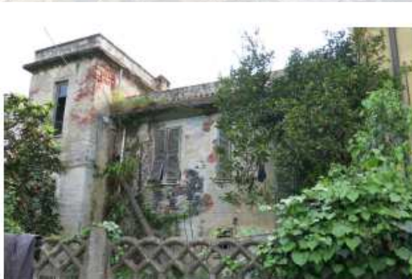
Edificio di proprietà comunale, prospetto Ovest
