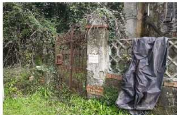
Particolare del cancello di ingresso
