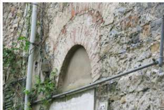
"Borgo Baceo", particolare del doppio arco in laterizio
