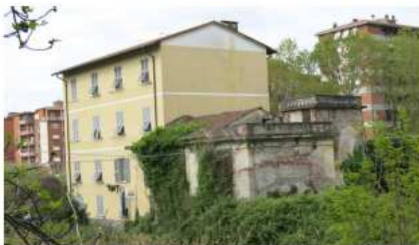
Edificio di proprietà comunale, prospetti Est e Nord
