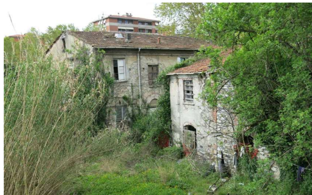
Veduta da Nord degli edifici storici di “Borgo Baceo”
