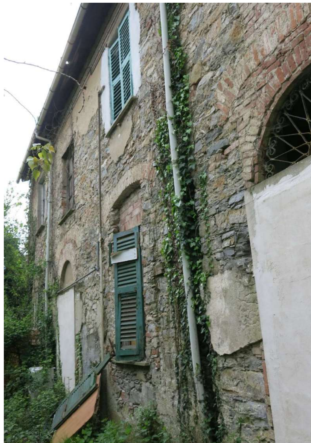
“Borgo Baceo”, prospetto dell'edificio meridionale
