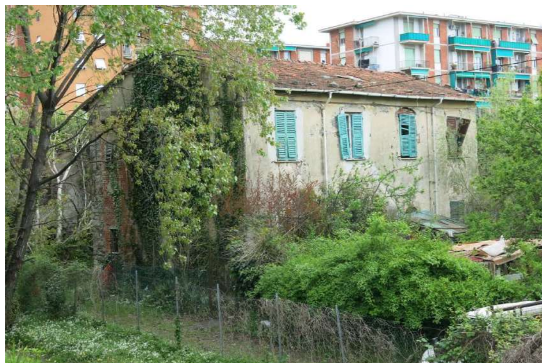
Veduta da Nord degli edifici storici di “Borgo Baceo”
