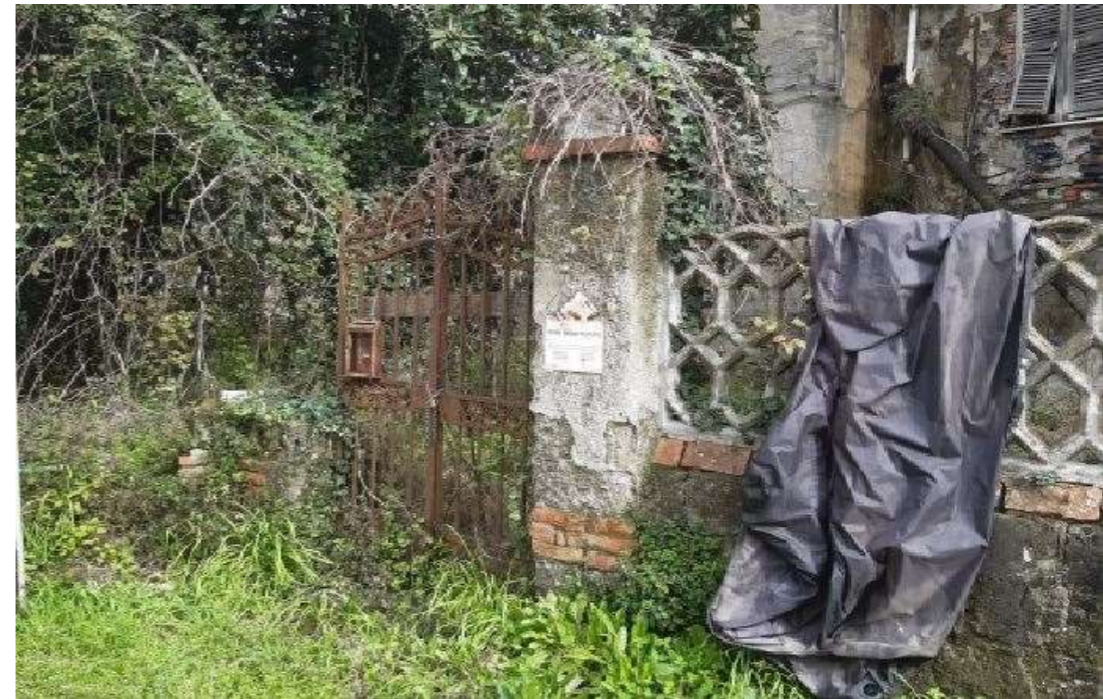
Particolare del cancello di ingresso
