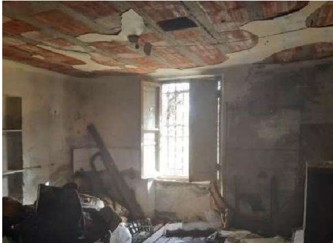
Edificio di proprietà comunale, interni
