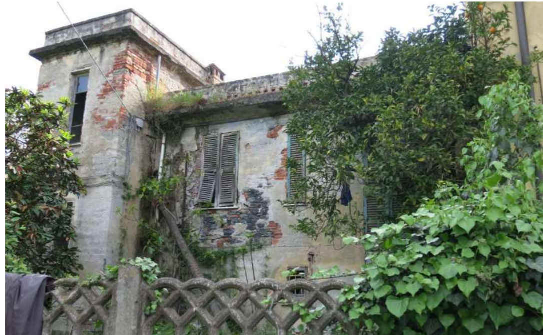
Edificio di proprietà comunale, prospetto Ovest
