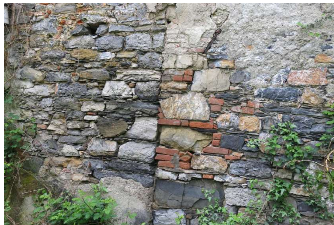
“Borgo Baceo”, particolare della tessitura muraria
