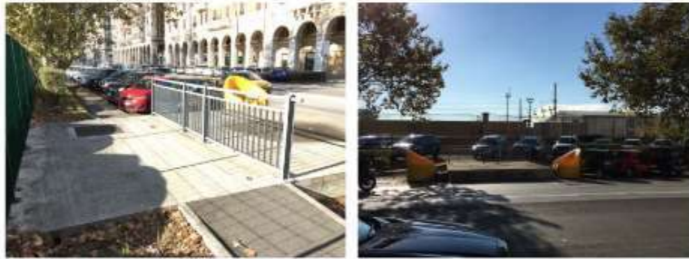
Figura 12 – Manufatto di rinforzo della copertura a valle di viale S. Bartolomeo in corrispondenza di via Piave, a monte dell'ingresso in area portuale.
