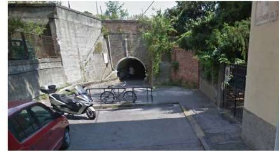
Figura 22 – Imbocco del sottopasso pedonale visto da monte; possibile sito di realizzazione di un elemento di contenimento dei livelli per prevenire l'allagamento del sottopasso stesso.
