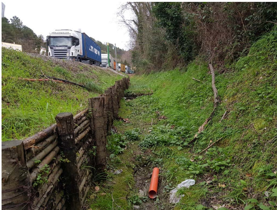
Foto 22 – La sez 33 verso monte
