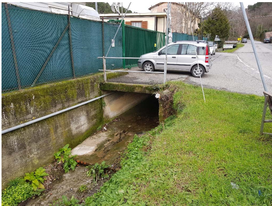
Foto 17 – La sez 26 verso monte
