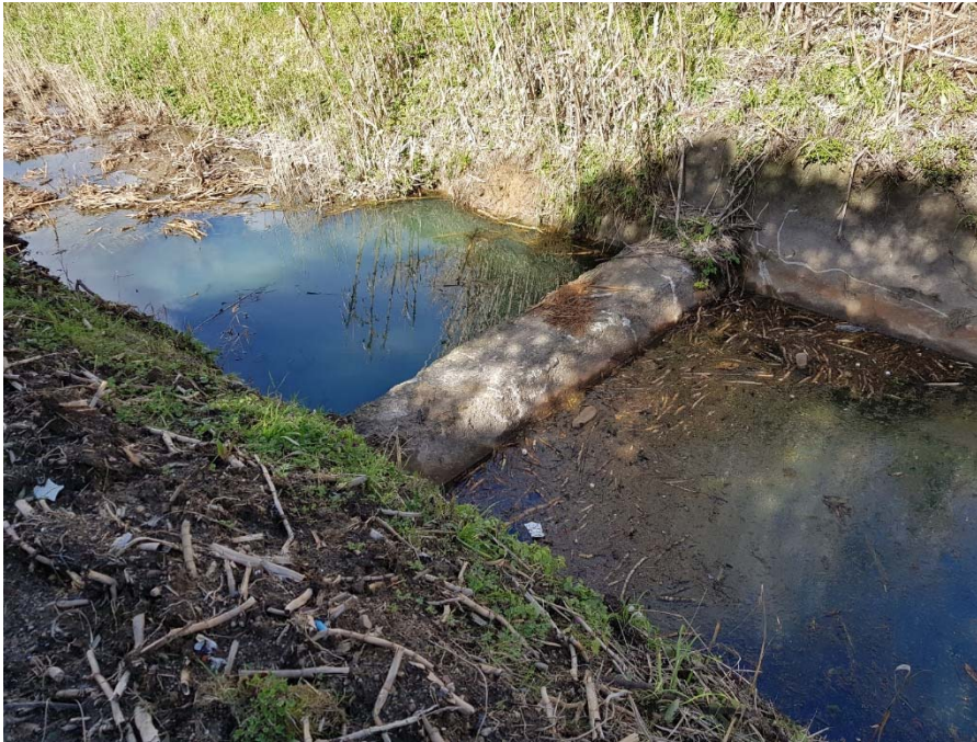
Foto 3 – Traversa in calcestruzzo nella sezione 6.5 ripresa dalla sponda sinistra
