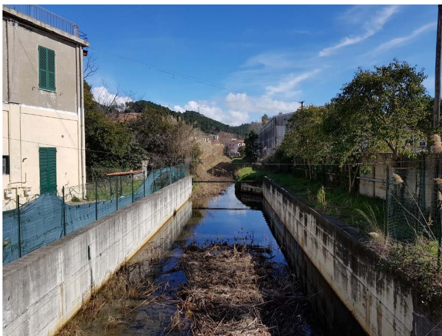
Foto 2 – Dalla sez 2 verso monte
