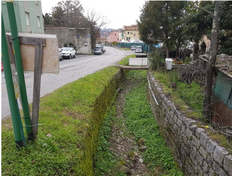
Foto 18 – Dalla sez 30 verso valle – il ponte 28.5
