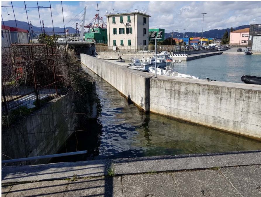
Foto 1 – Sbocco del fosso di Pagliari nella darsena, ripresa dalla sez 1 verso la sez 0
