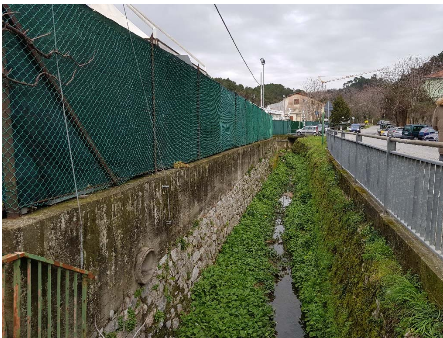
Foto 15 – Dalla sez 24 verso monte
