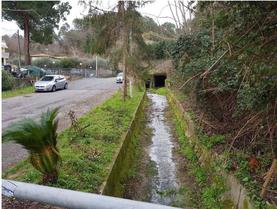
Foto 24 – Dalla sez 35 verso monte
