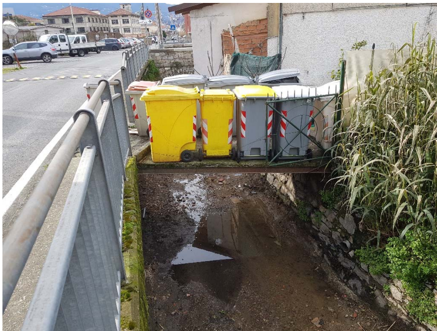
Foto 12 – La sez 16 verso valle – la passerella 15.5
