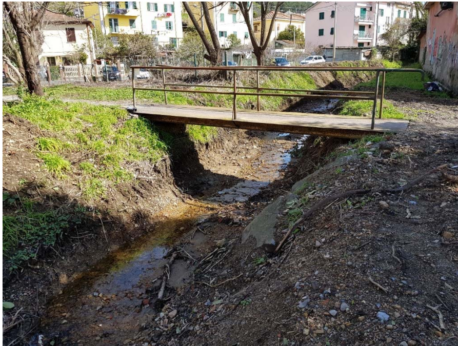
Foto 5 – La sezione 8 verso monte – Passerella 8.5
