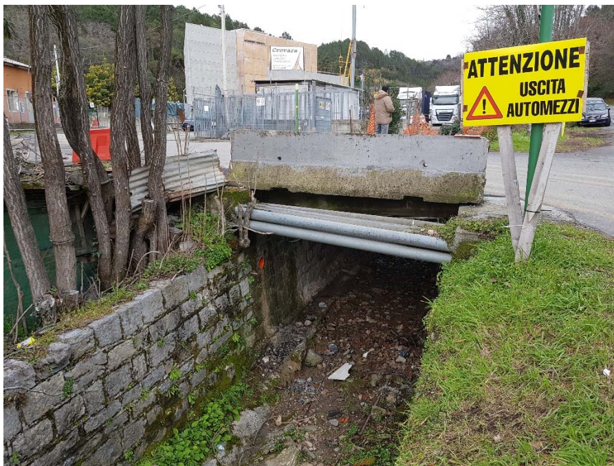
Foto 19 – La sez 30 verso monte
