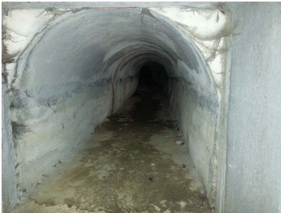
Foto 27 – Dalla sez 37 verso monte – sbocco della tombinatura
