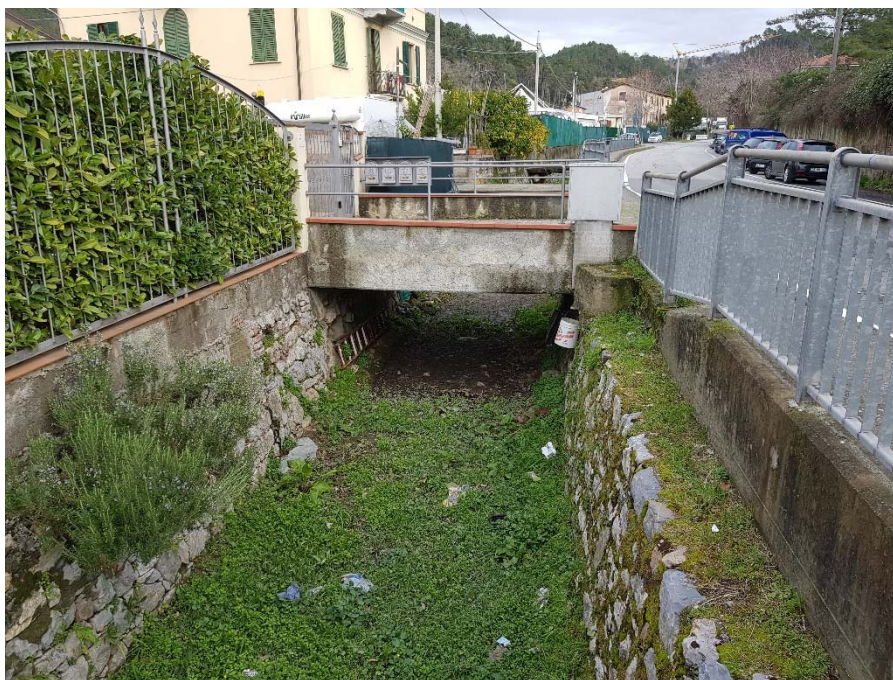
Foto 14 – Dalla sez 18 verso monte – il ponte 19.5
