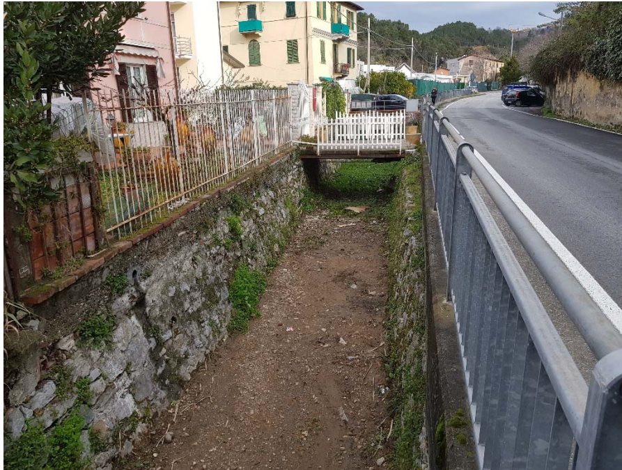
Foto 13 – Dalla sez 16 verso monte – il ponte 17.5
