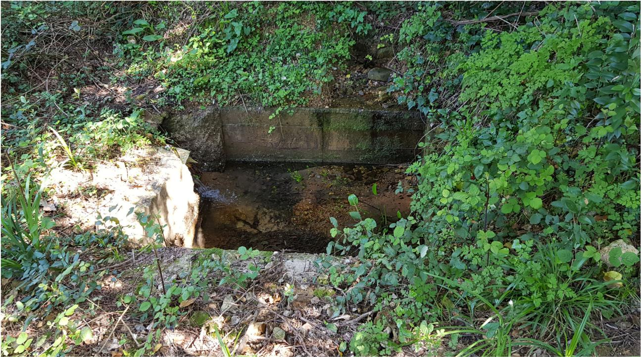
**Foto 03** – Uno dei due pozzetti, quello in destra, che generano il tratto di valle del canale. Il pozzetto riceve l'apporto di una piccola condotta interrata proveniente dal lungo fabbricato sottostante il raccordo stradale
