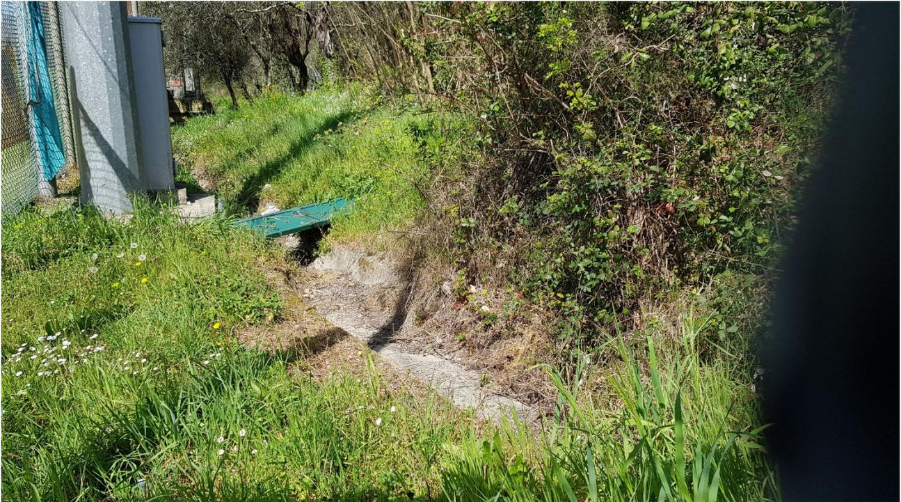
**Foto 01** – La canaletta di regimazione in cemento a cielo aperto che scorre a lato del campo sportivo costituisce il tratto di monte a cielo aperto del corso d’acqua. La vista è da monte verso valle, sulla destra del campo.
