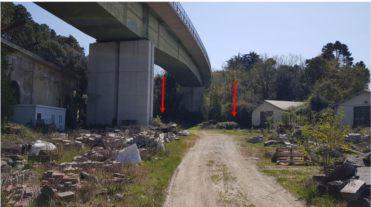
**Foto 02** – Da valle verso monte, il sedime del tracciato tombinato: in fondo la posizione dei due pozzetti a cielo aperto a valle della struttura di trattenuta posta lateralmente (sia in destra che in sinistra) alla pila del viadotto - con la freccia rossa l’ubicazione dei pozzetti
