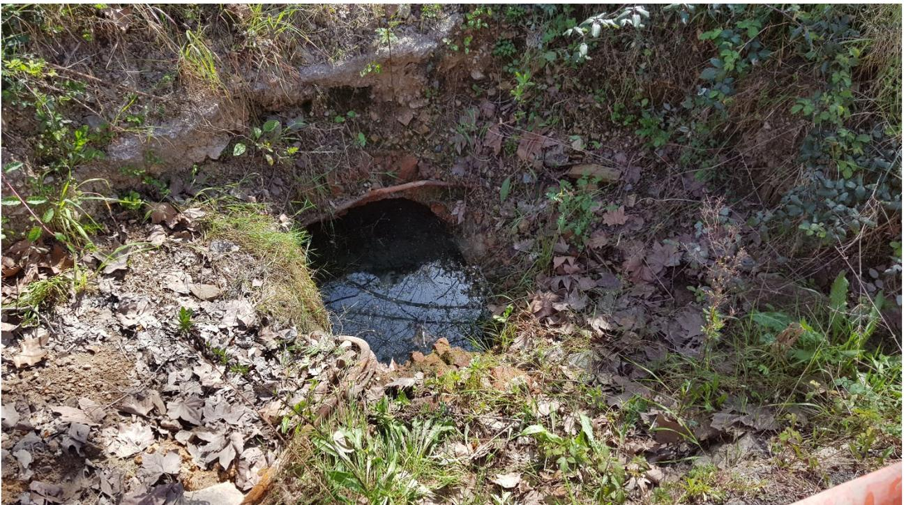
**Foto 08** – Il tratto tombinato di antica realizzazione, successivo alla più recente struttura in calcestruzzo armato che lo ha sostituito, che risulta ostruito in corrispondenza del marciapiede stradale, verosimilmente a monte dell'intersezione con la nuova condotta da 1200 mm. Il tratto della foto, con il cielo asportato e vista di acqua stagnante, è posto circa 10 metri a monte dell'ostruzione (rivelata con videoispezione in data 01/04/2021).
