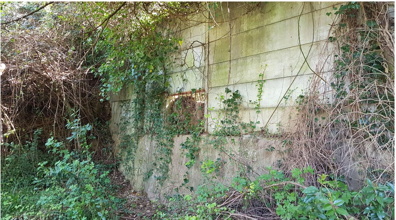
**Foto 04** – Dal pozzetto di cui alla foto 03 si nota la struttura in calcestruzzo armato, muro di base in calcestruzzo e pannelli sovrastanti in conglomerato cementizio prefabbricato, con presumibile funzione di briglia selettiva: si nota la luce con griglia metallica, colma a monte di depositi.
