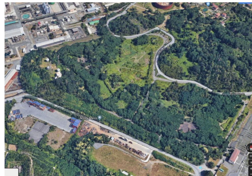
Vista satellitare area Bacini di Lagunaggio
