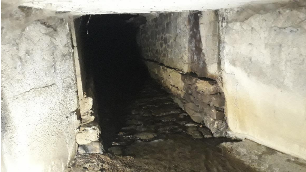
Foto 7: tombinatura Vecchia Dorgia in corrispondenza attraversamento ferroviario (valle)
