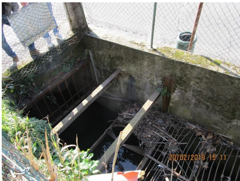
Foto 2: imbocco tratto tombinato
