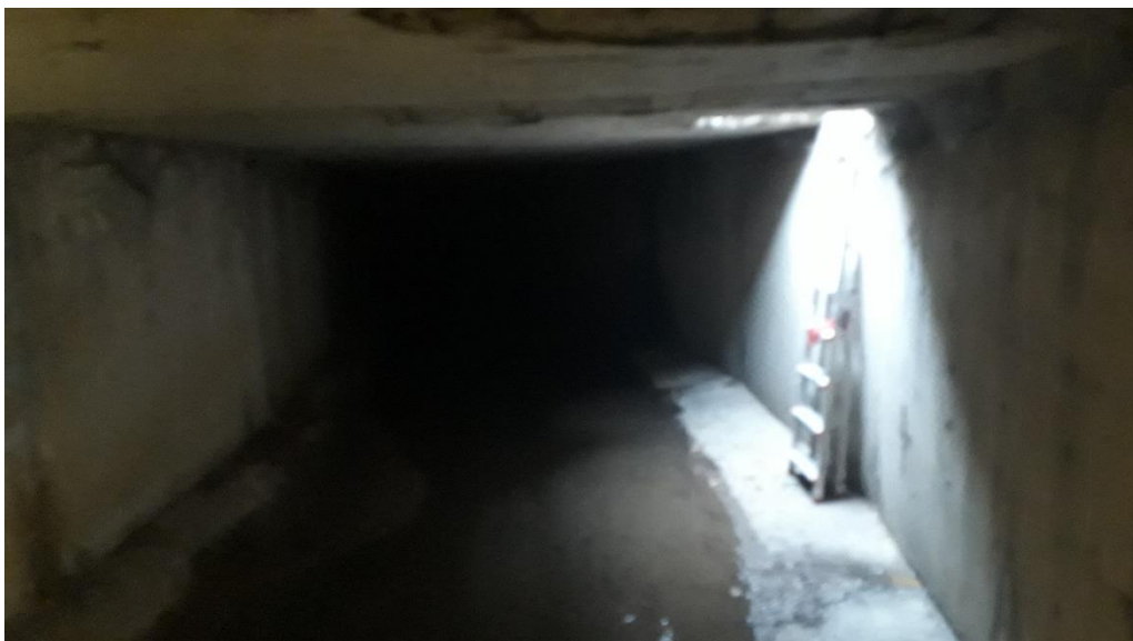
Foto 8: tombinatura Vecchia Dorgia a valle attraversamento ferroviario
