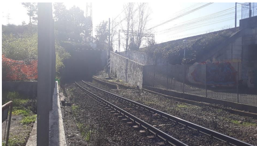
Foto 7: imbocco galleria linea ferroviaria “bassa”
