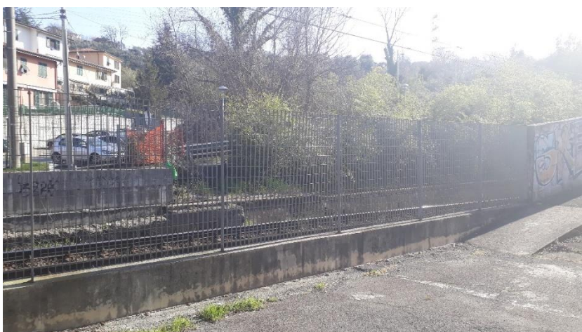
Foto 4-5: muro di confine a valle della linea ferroviaria
