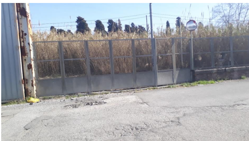
Foto 11: cancello in corrispondenza di Via Maralunga
