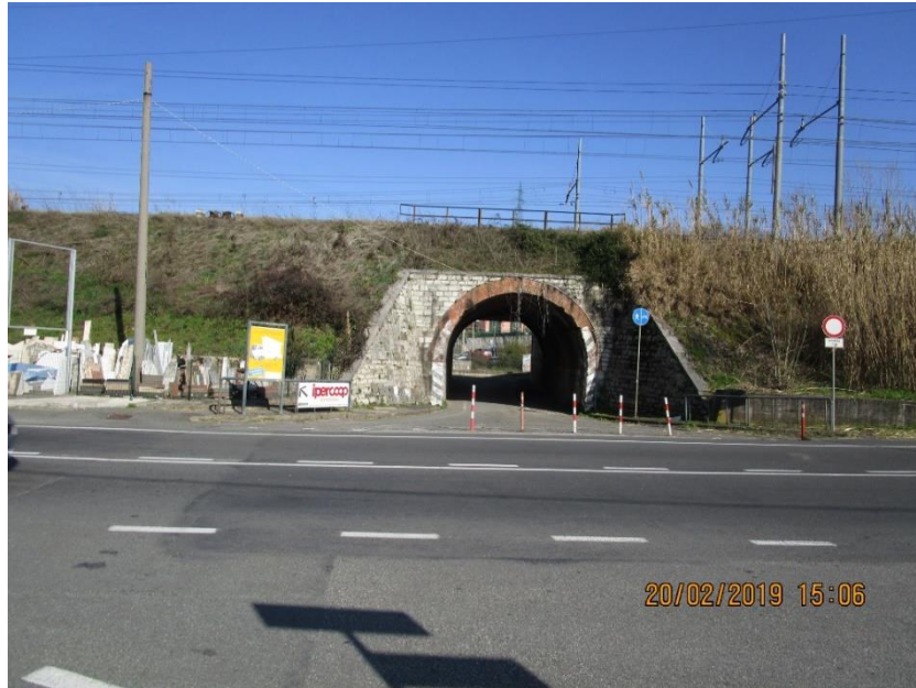
Foto 6: sottopasso di Via della Pieve
