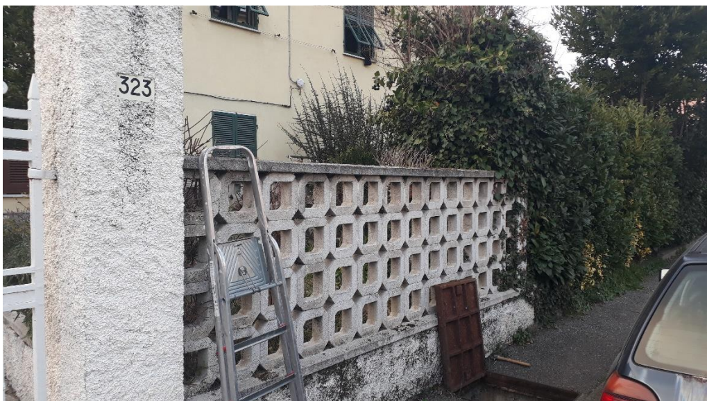
Foto 3-4: Tombinatura Vecchia Dorgia in corrispondenza del civico 323 di Via della Pianta
