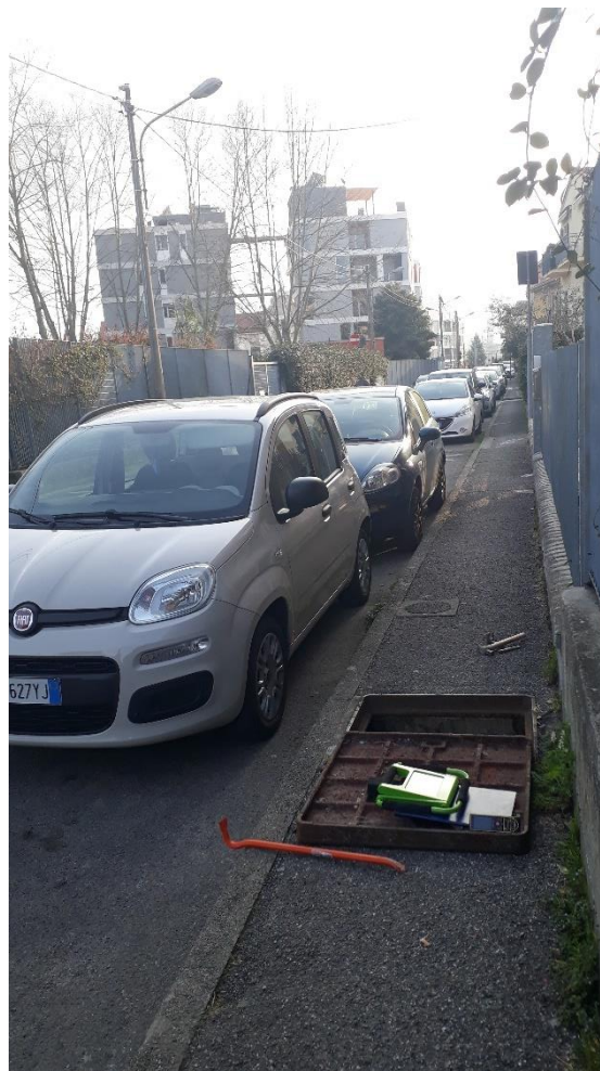
Foto 5-6: tombinatura Vecchia Dorgia in corrispondenza del campo sportivo
