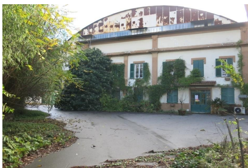
Il fronte principale dello stabilimento
