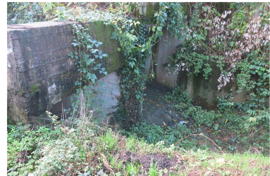
Il punto in cui il Rio Pagliari scorre al di sotto delle strutture dello stabilimento
