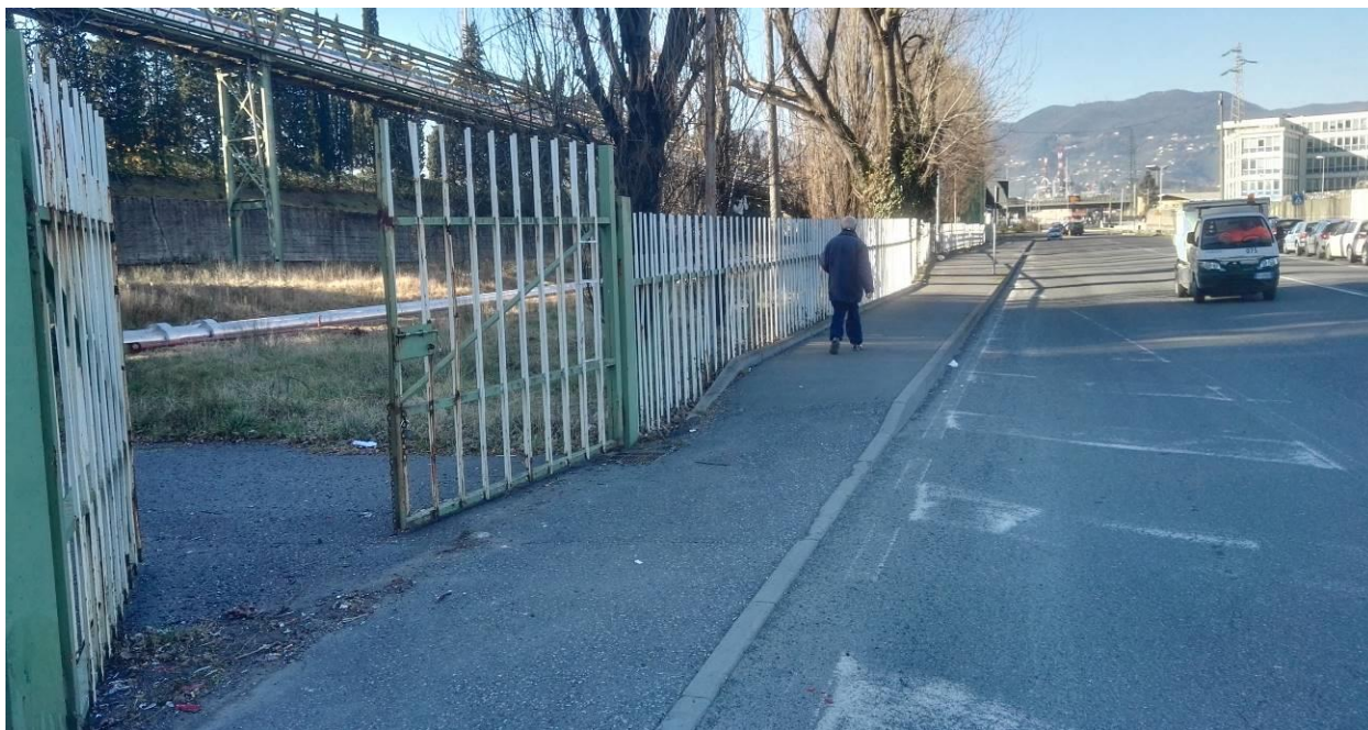
Figura 23: Ripresa dell'area ENEL lungo Via Valdilocchi in sinistra idraulica al Canale Fossamastra. La recinzione che delimita la proprietà privata è il limite del modello idraulico monodimensionale. Si rileva una differenza di quote tra interno ed esterno, con l'area di proprietà Eneòl ,interna alla recinzione, chiaramente depressa rispetto alla quota del piano stradale.
