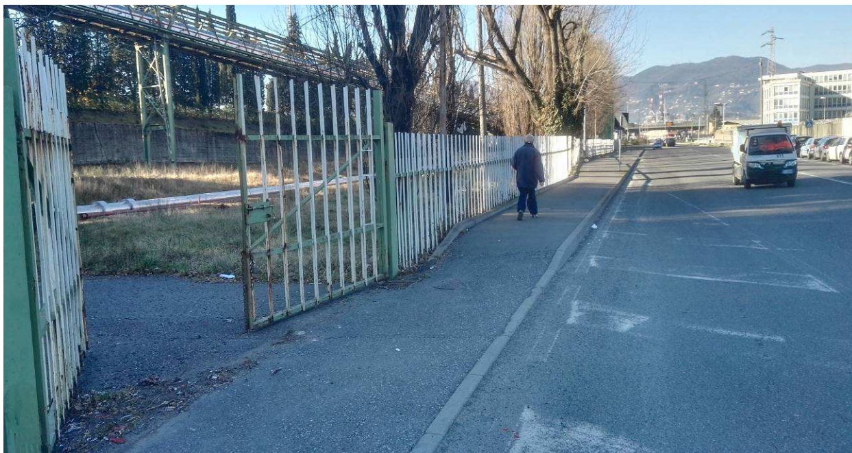
Figura 21: Ripresa dell'area ENEL lungo Via Valdilocchi in sinistra idraulica al Canale Fossamastra. La recinzione che delimita la proprietà privata è il limite del modello idraulico monodimensionale. Si rileva una differenza di quote tra interno ed esterno, con l'area di proprietà Eneòl ,interna alla recinzione, chiaramente depressa rispetto alla quota del piano stradale.
