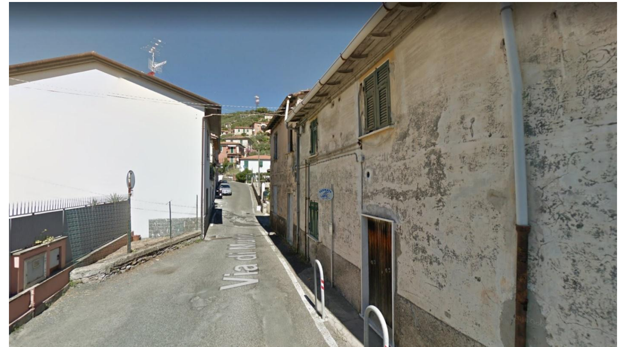
Foto.1 Problematiche presenti in un tratto di Via di Murlo
