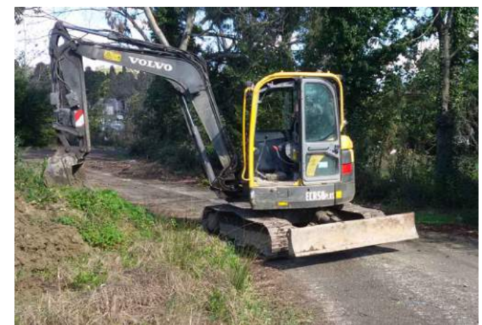
ESECUZIONE SCAVO POZZETTI
