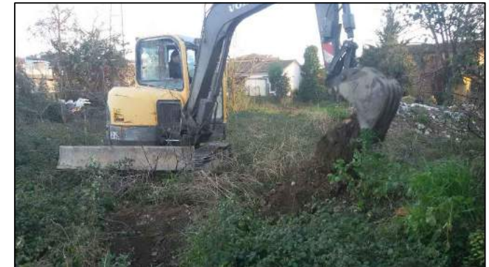
ESECUZIONE SCAVO POZZETTI
